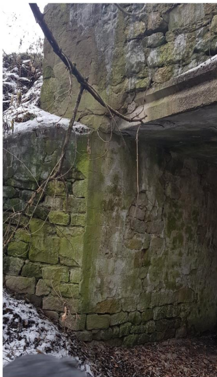
Стан водопропускної труби до ремонту
