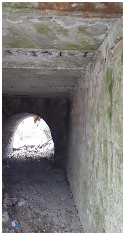
Стан водопропускної труби до ремонту
